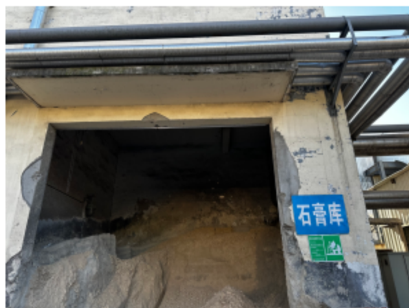
ts001 脱硫石膏储存库
