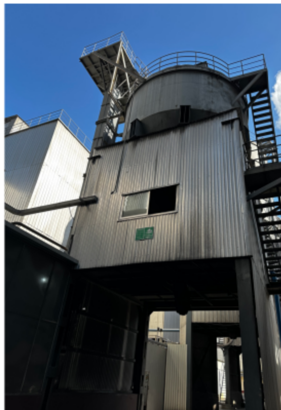
ts002 炉渣储存库
