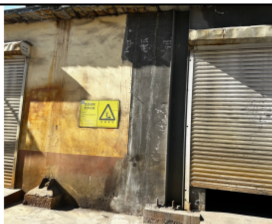
ts006 废机油储存库
