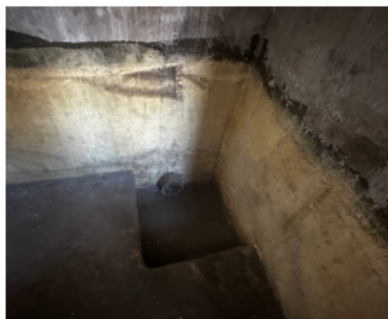
危废暂存库内部-收集池
