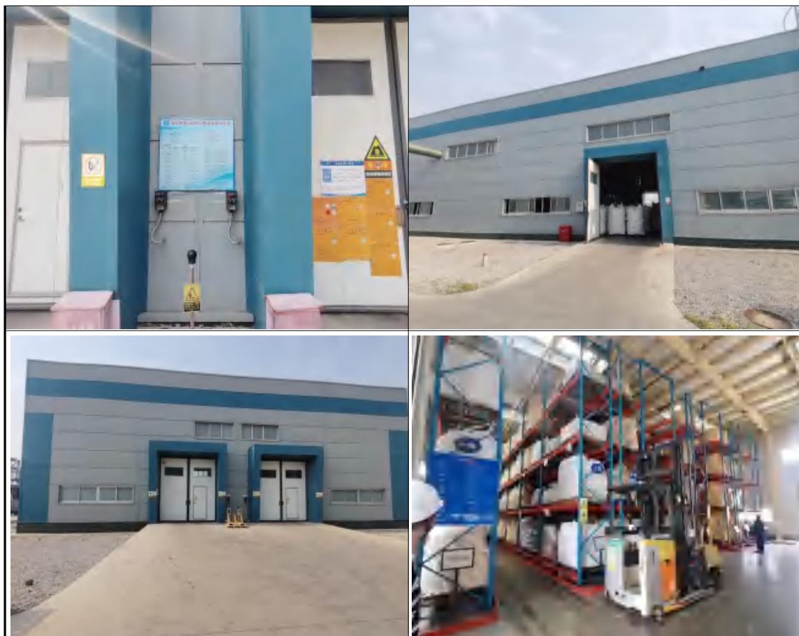
图 4.1-7 原料及成品仓库现场排查照片一览表
