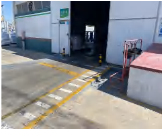
原料库门口缓坡
