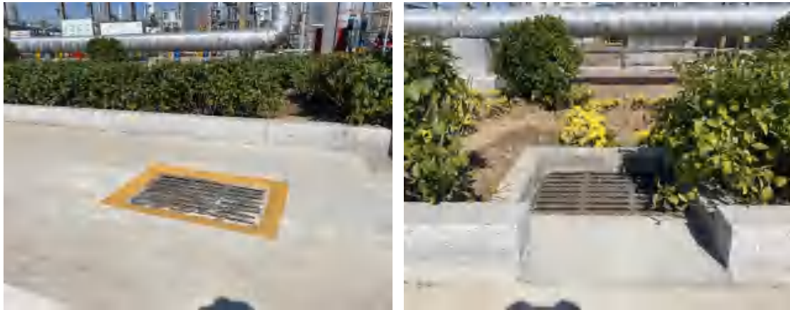
非硬化区域铺设路沿石
