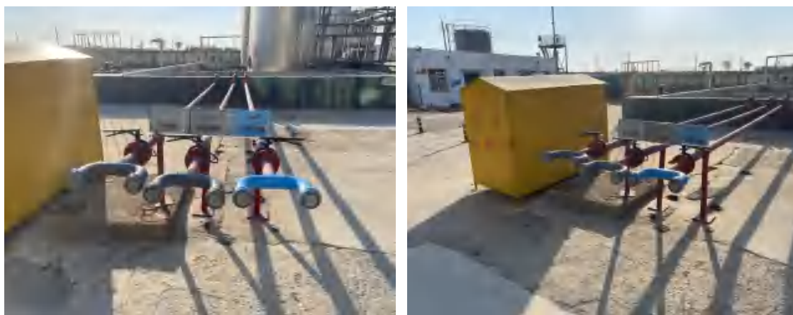
莠去津罐区卸车区域
