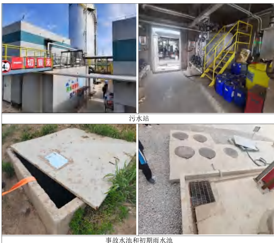
图 4.1-2 厂区内池体现场情况图
