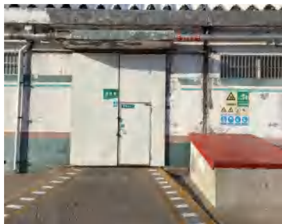
一般工业固废库门口缓坡
