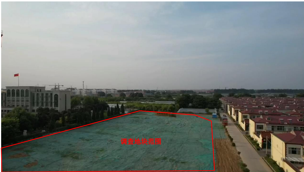
调查地块航拍现状（2022.9）
