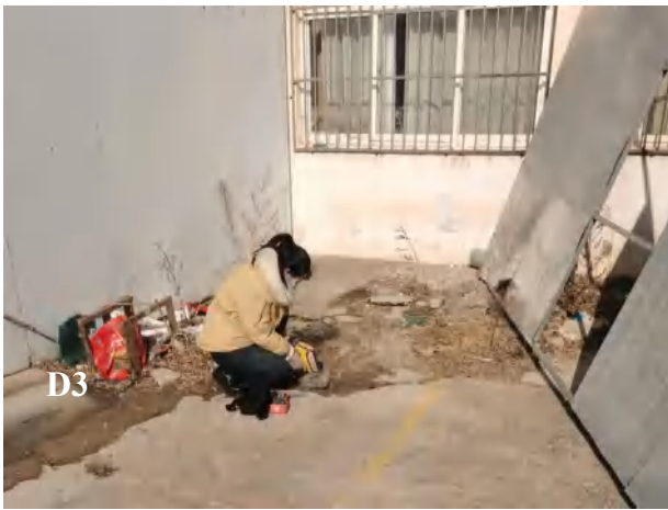
原饭馆西侧区域
