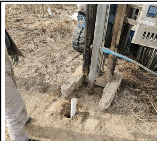
W2 地块内地下水 2#建井下管照片
