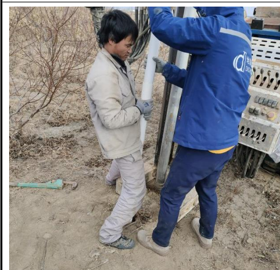
W3 地块内地下水 3#建井下管照片
