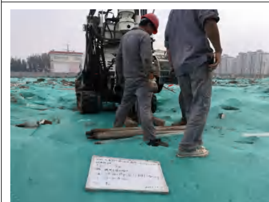
S3 土壤钻探取样
