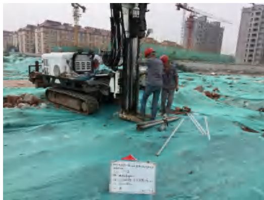
S2 土壤钻探取样
