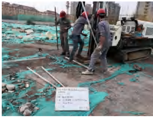
S1 土壤钻探取样
