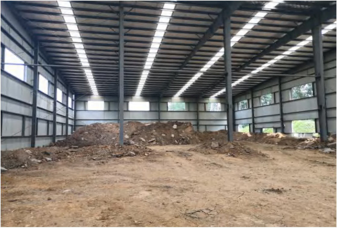
地块仓库内部
