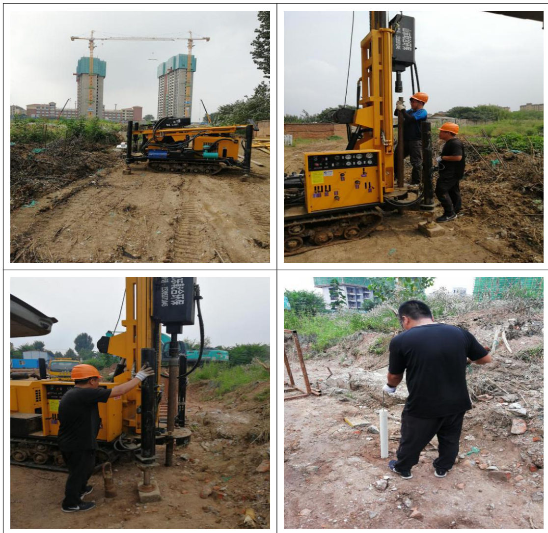
图 5.2-2 建井现场照片
